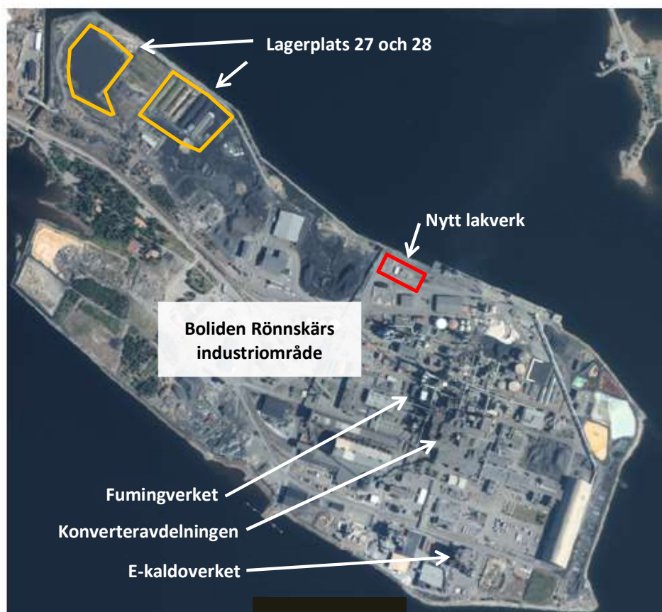
Figur 2-1 Flygfoto över Bolidens Rönnskärs industriområde med det nya lakverket, lagerplatser och verksamhetsanläggningar markerade i bilden.
