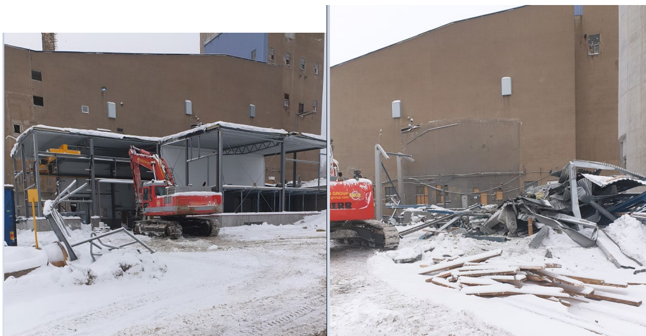
Sandpumpstationen till vänster och återstoden av kvarn 10-hallen till höger (februari)
