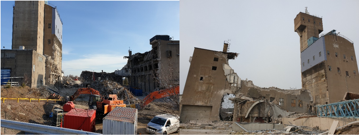
Rivning av huvudbyggnaden på anriktningsverket (april).
