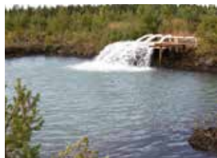
Kedträsk, september 2012. Vid tömning av dagbrottet kalkades vattnet i flera omgångar. Vattnet samlades upp i bassänger i syfte att omhänderta slam samt kontrollera vattenkvaliteten.
