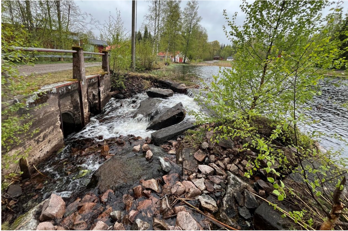
Figur 9. De befintliga uttjänta trummorna och den fasta tröskeln. Herrgårdsdammens södra sida syns i bakgrunden.
