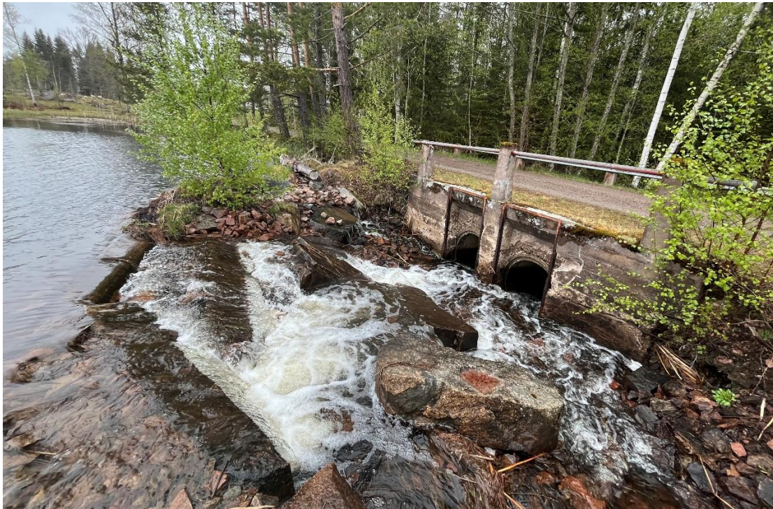
Figur 8. Dammens befintliga uttjänta trummor som leder vattnet under vägen och den fasta tröskeln (dammens östra sida).
