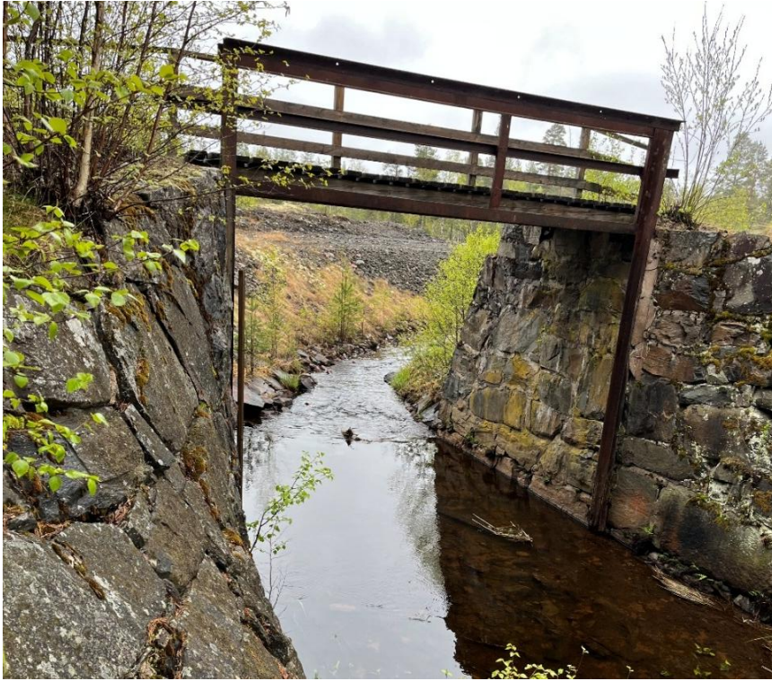
Figur 6. Foto av utloppet G4 som visar anläggningens nuvarande utformning. (Foto Sweco, 2026).
