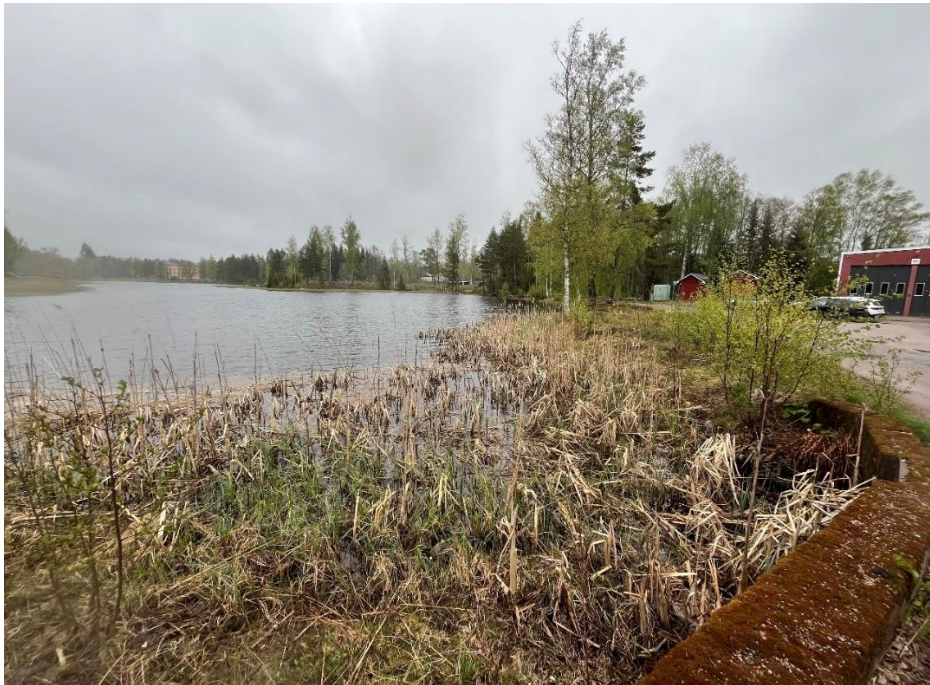
Figur 11. Bild tagen från Herrgårdsdammens södra sida (dammkonstruktion med befintliga äldre trummor och tröskel uppe till höger i bild intill skogspartiet).
