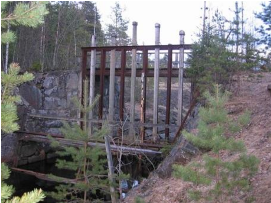
Figur 5. Foto som visar den gamla dammluckan och uttjänta sättare som togs bort i och med att Boliden genomförde dammsäkerhetshöjande åtgärder.
