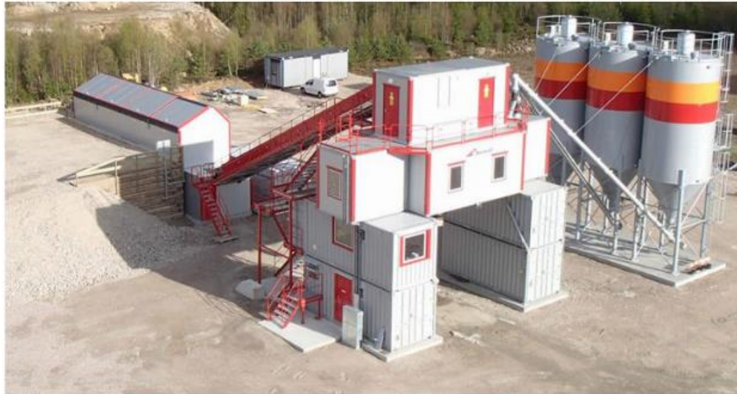
Figur 12. Exempel på anläggning för lagring och blandning av paste (Källa: Paterson & Cooke, 2022)
