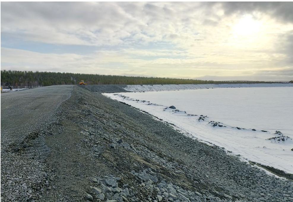
Kuva 6-10. Rikastushiekka-altaan A vaiheen 8 märän puolen luiskan eroosiosuojausta.
