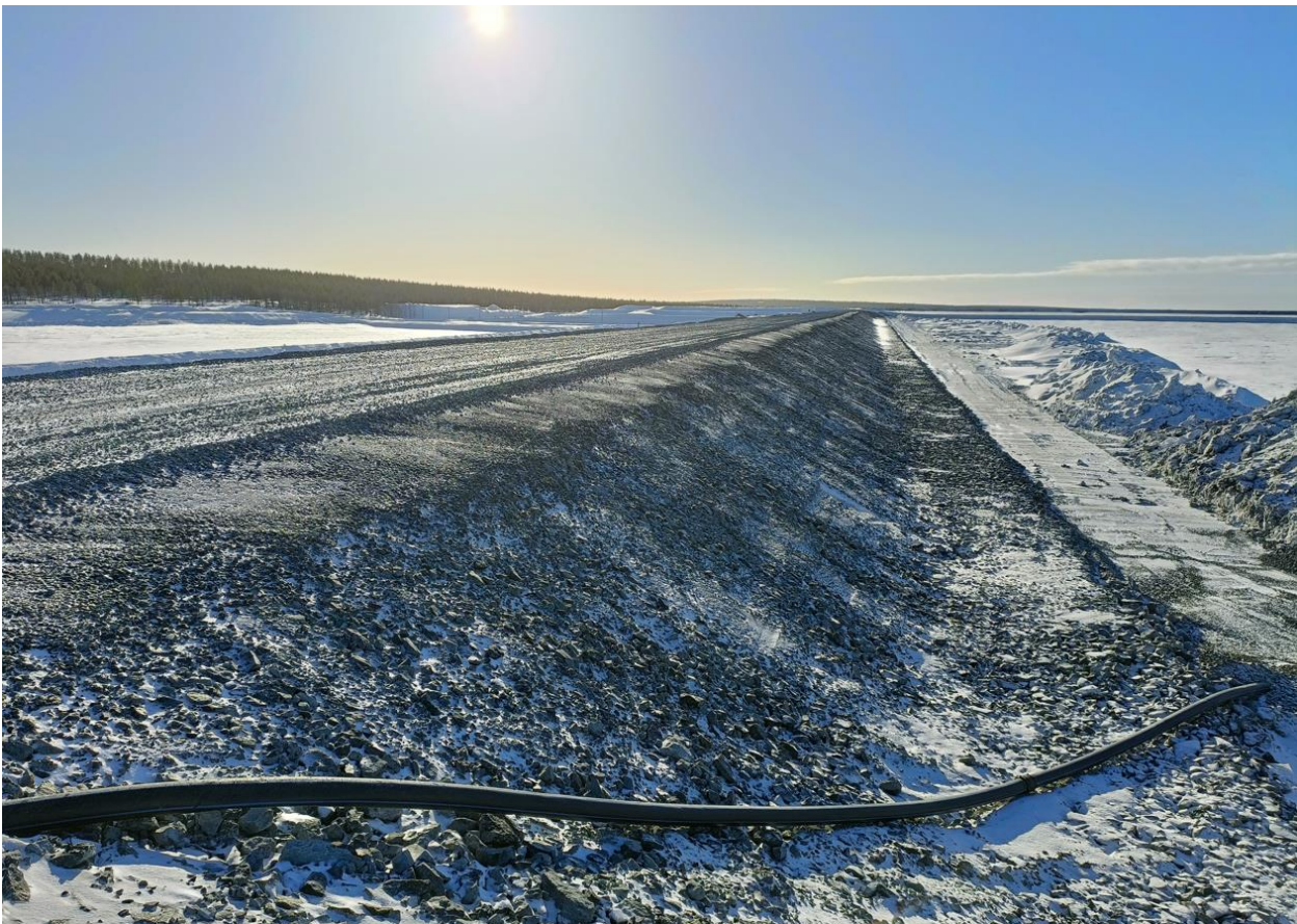
Kuva 6-9. Rikastushiekka-altaan A vaiheen 7 märän puolen luiskan eroosiosuojausta.
