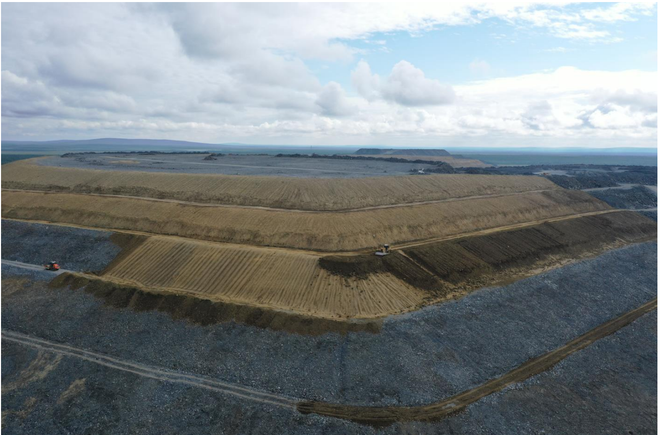
Kuva 6-13. Sivukivialueen peittorakenne
