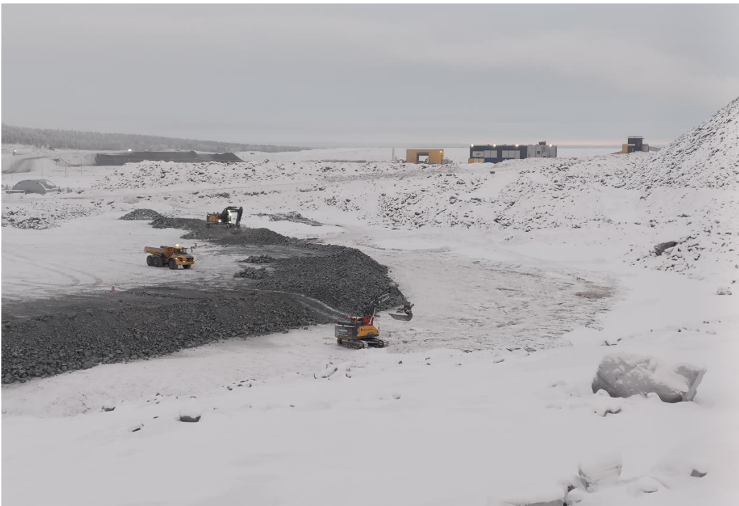
Kuva 6-12. Sivukivialueen 1a laajennus.
