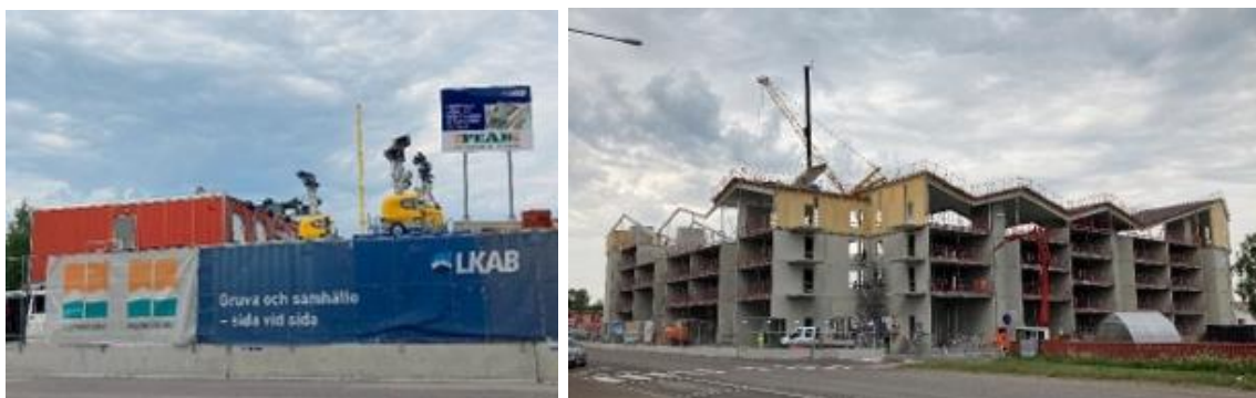
Figur 35: Kvarteret Gladan, med 85 lägenheter och butiker, i centrala Gällivare byggs av LKAB som ersättning för delar av Topbstädernas fastighetsbestånd i Malmberget. Foto Hifab AB, 2023.
