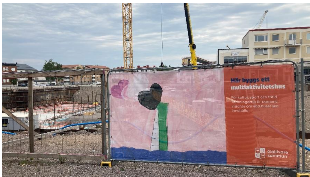
Figur 39: Mitt i centrala Gällivare byggs "Multiaktivitetshuset", Foto: Hifab AB
