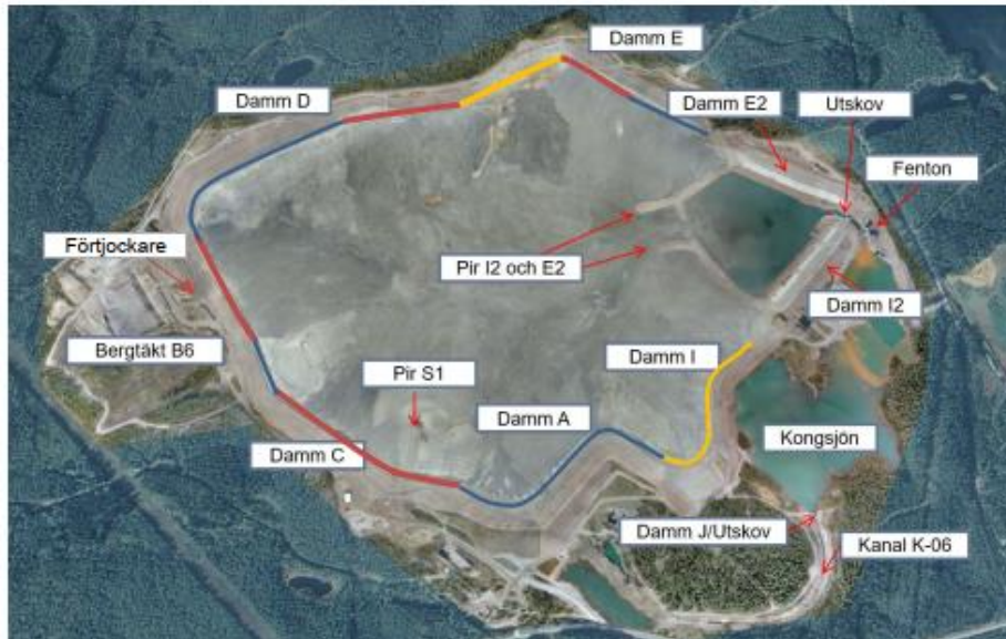
Figur 2. Översiktsplan av Ryllshyttemagasinet (flygfoto 2019). De blå linjerna representerar sektioner där dammarna initialt byggts med en startdamm av morän, grundlagda i huvudsak på morän, men som sedan höjts inåt med deponerad anrikningssand. Övan startdammen har ett inre dränagesystem installerats. De röda linjerna visar sträckor där dammarna byggts som helt dränerande inåtdammar grundlagda på berg och med ett inre dränagesystem. Den gula linjen representerar damm I och del av damm D som byggts som dränerad damm, grundlagd på berg men utan inre dränagesystem.
